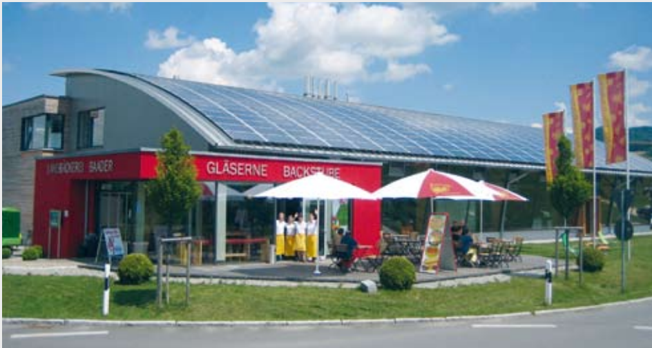
Landbäckerei Baader in Frickingen: 220 Jahre Handwerkstradition zeigen ihre innovative Seite – unter anderem mit einer Solaranlage auf dem Dach.
