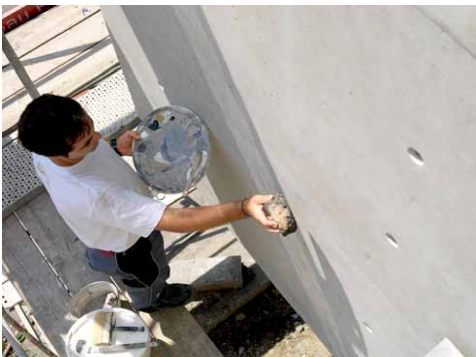
Existenzgründer und Übernehmer verwirklichen neue Ideen – wie Meinrad Kopp: Sichtbetonkosmetik KOPP entwickelte ein innovatives Verfahren, das Altersschäden, Verschmutzungen, Montageschäden und Rostflecken bei Sichtbeton spurlos verschwinden lässt.
